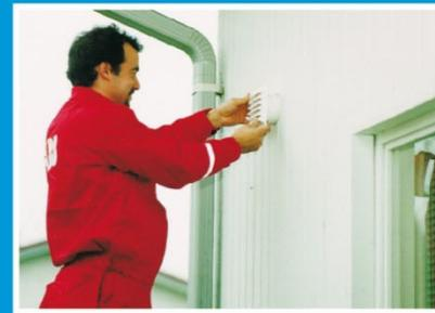
Utanför installeras med ventilen kommande yttergaller. Om en redan existerande uteluftsöppning används bör, med ventilen kommande uteluftsröret, anpassas i öppningen så att filter passar i den.
