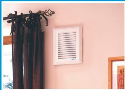
Ventilen installeras i sovrummet eller annat torrt utrymme. Ventilen placeras på ytterväggen i rummets övre del, ventilens överkants avstånd från taket min. 200 mm. Fastsättning i väggen med hjälp av fästningsramen. Elanslutning till kontaktdosan med en 5 m lång sladd. Sladden kan placeras bakom en list eftersom driftsspänningen är 12 V.
