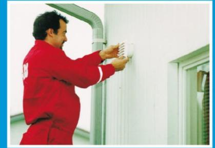
Ulkopuolelle asennetaan laitteen mukana tuleva ulkosäleikkö. Mikäli käytetään olemassa olevaa ulkoilma-aukkoa, tulee aukkoon sovittaa laitteen mukana tuleva ulkoilmaputki jotta suodatint sopii siihen.
